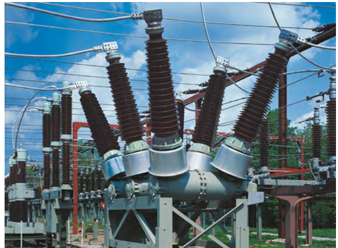
Fig. 4.1-12: SPS2/3AP1 DT 145 kV
