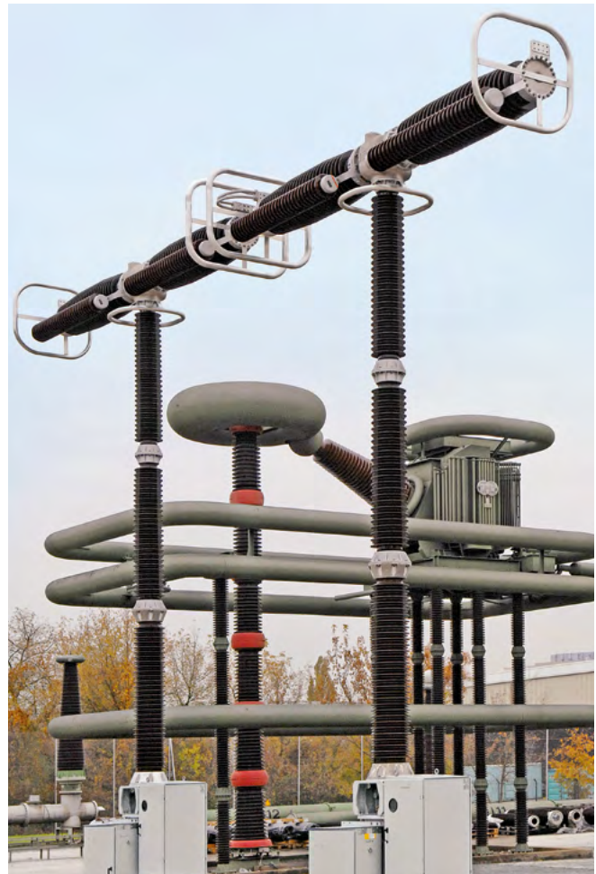
Fig. 4.1-5: 3AP4 FI 800 kV pole
