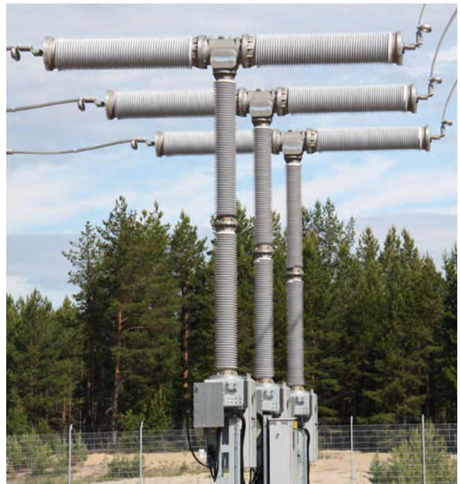
Fig. 4.1-23: 3AP2 DCB 420 kV
